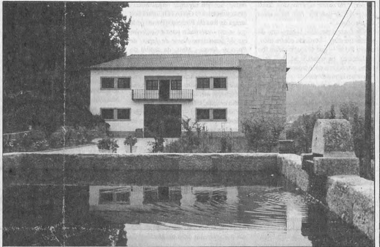
O actual edifício das oficinas gráficas e d'O GAIATO, em Paço de Sousa, na objectiva do Jorge Cruz, cuja arte aproveita o reflexo do belo imóvel — na água do tanque.
